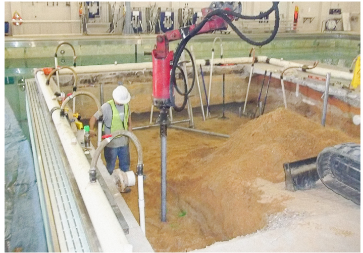
Installing HP288 piles
